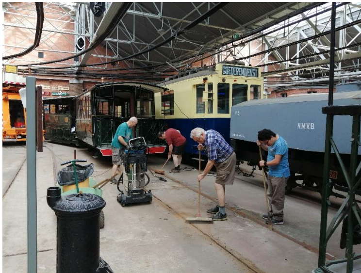
Het spoor na tientallen jaren weer berijdbaar maken, ook dat is voorbereidend werk. (B.Morren)
